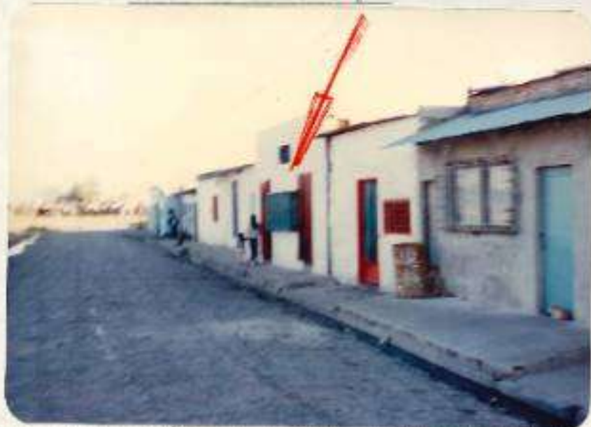
Ítem 5 ; vista panorámica de calle Alberti tomada desde calle Montaña hacia calle Alberti, donde se observa edificaciones de carácter precario.-----
