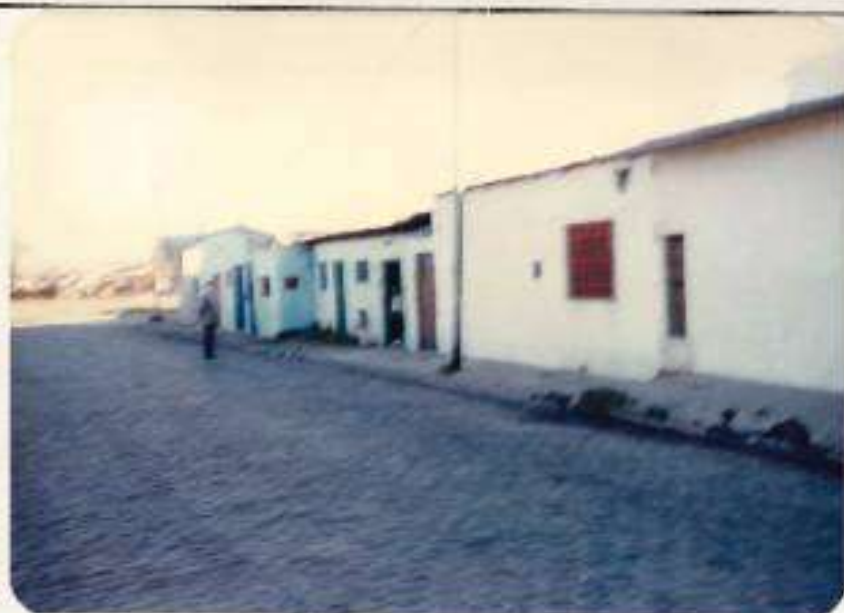
7. Allica , vista calle Alberti tomada desde intersección con la calle Montaña, observándose el frente de las edificaciones.
