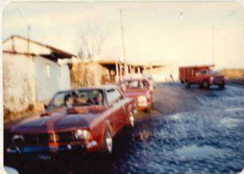
Inicio ; vista panorámica de calle Montaña a intersección - Alberti, observándose parte antiguo puente Acceso-suroeste como inundado. - - - - -
