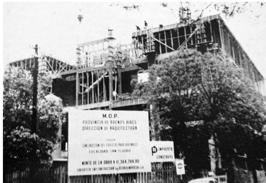
El edificio de Tribunales de la calle Ituzaingó, en construcción (año 1976)
